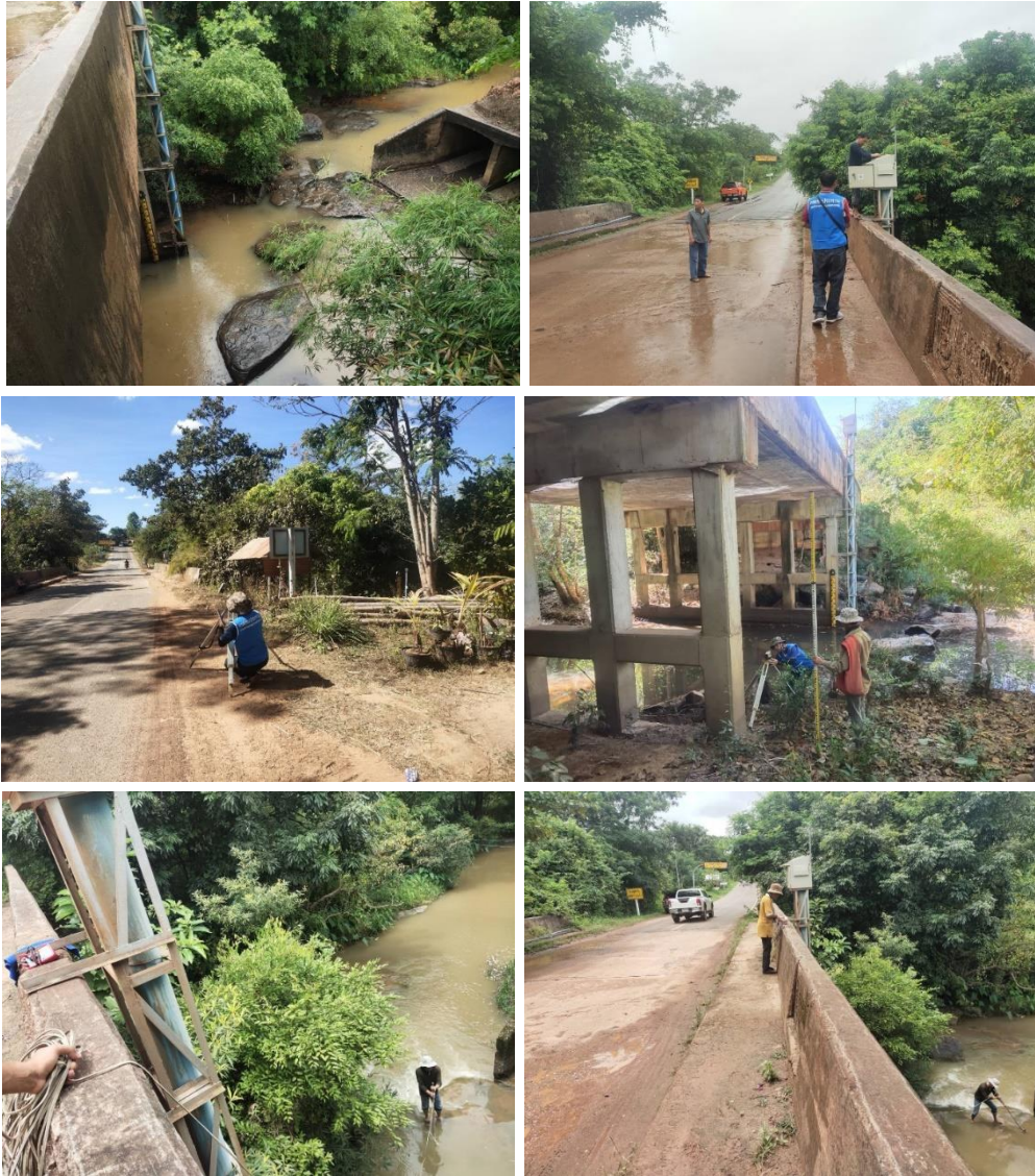
รูปที่ 5.2.2-17 การสำรวจรูปตัดขวางลำน้ำและสำรวจปริมาณน้ำ สถานี Kh.119 บ้านห้วยตาเปอะ ตำบลบ้านค้อ อำเภอดำชะอี จังหวัดมุกดาหาร
